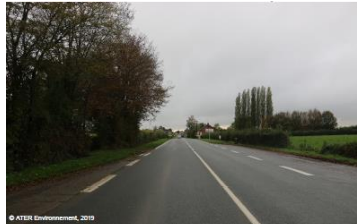
Figure 112 : Axe routier N2 en direction d'Etréaupont (source : Ater Environnement)
