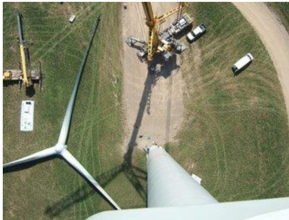
Figure 150 : Aire de grutage
