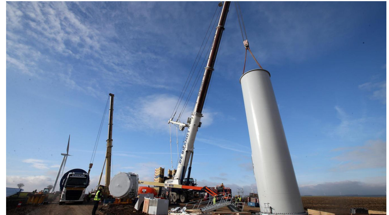
Figure 152 : Levage d'une section de mât
