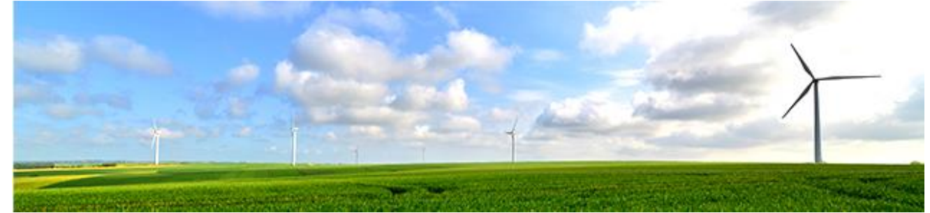
Figure 137 : Parc éolien du Mont Huet (source : Escofi)
