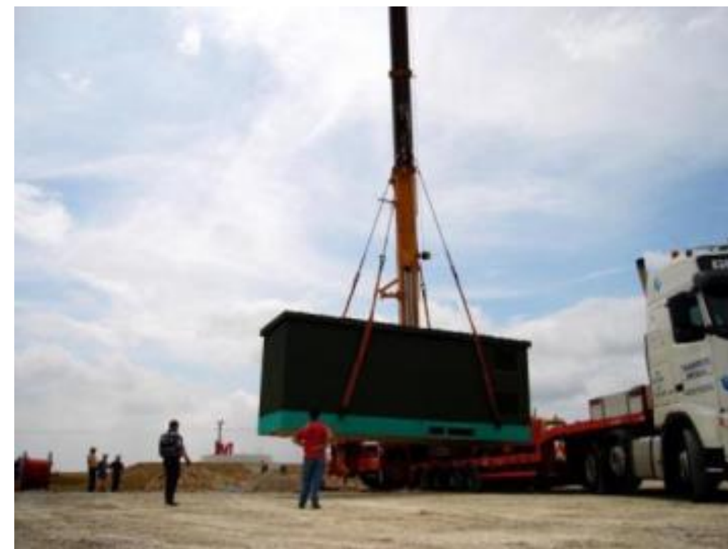
Figure 145 : Pose d'un poste de livraison
