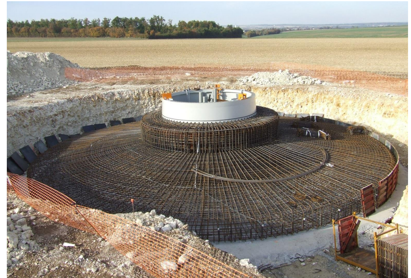
Figure 151 : Ferrailage d'une fondation
