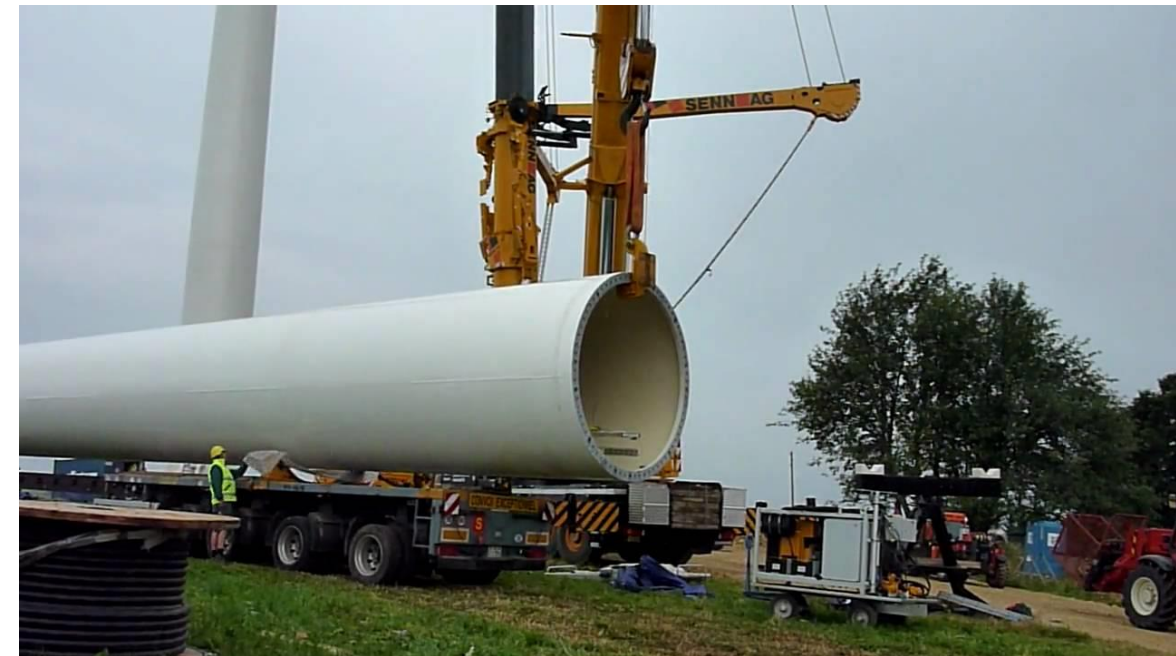
Figure 142 : Assemblage d'une section de tour
